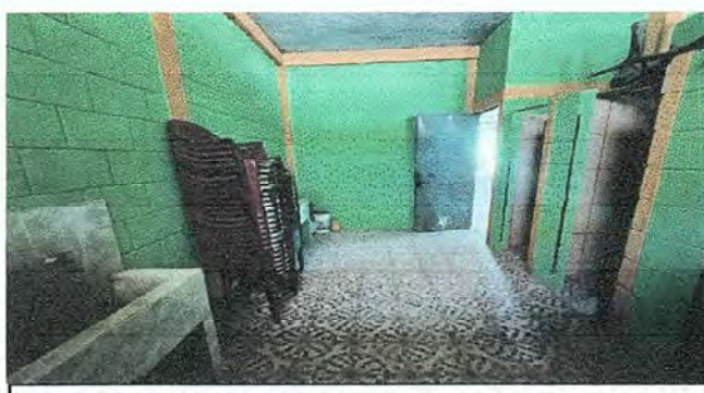
Foto 12: Sustrucción de Torta de Concreto por Piso Cerámico, Módulo de Baños.
