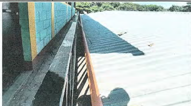
Foto 7: Sustrucción de Canal de PVC. Módulo 3.
