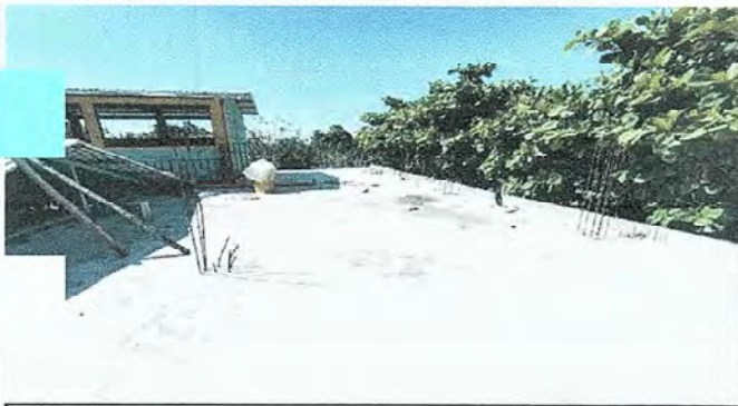
Foto 3: Impermeabilización de losa y Reparación de Pañuelos.
