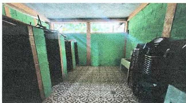
Foto 9: Pintura en muros interiores, Módulo de Baños.
