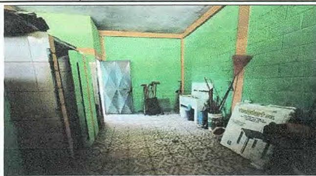
Foto 8: Pintura en muros interiores, Módulo de Baños.
