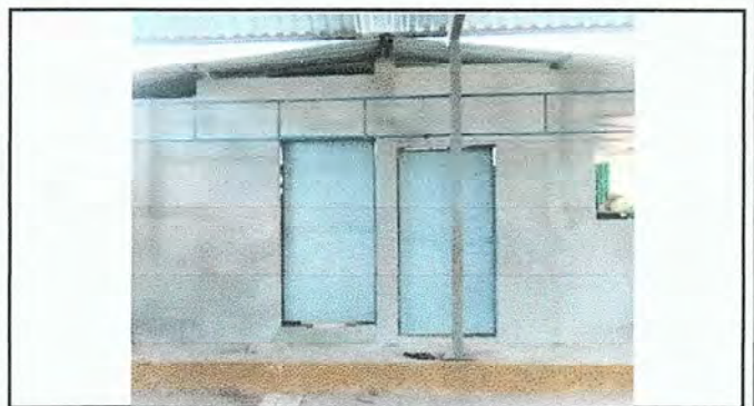
Foto 4: Fabricación e Instalación de puertas de metal en Módulo 1.
