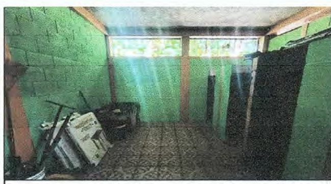
Foto 11: Sustrucción de Torta de Concreto por Piso Cerámico, Módulo de Baños.
