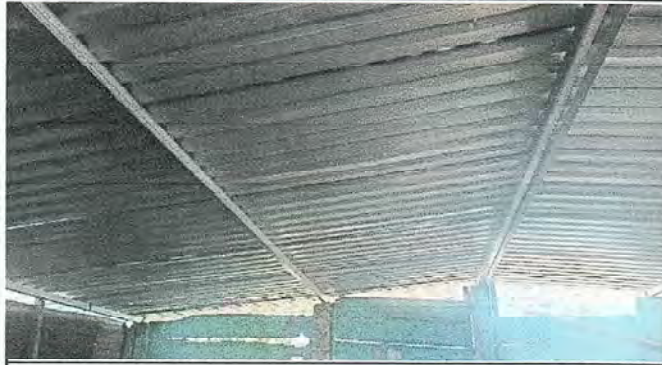
Foto1: Sustrucción de lámina por lámina troquelada ALUZINC Cal.26. Módulo 1.
