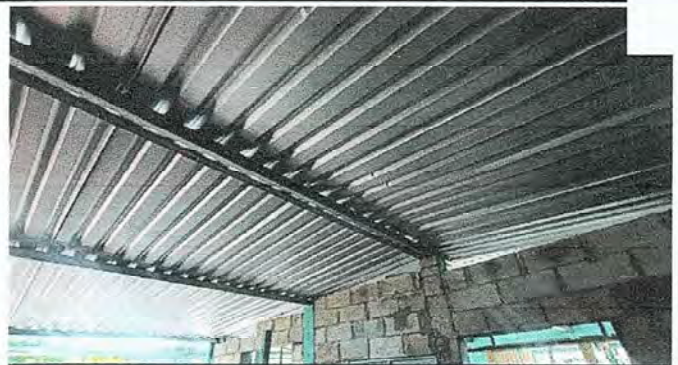
Foto 2: Sustrucción de estructura de soporte de madera por metal. Módulo 1.
